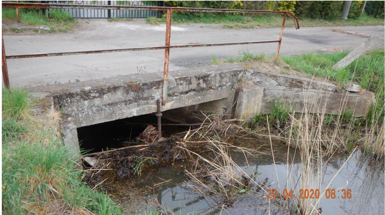
Budowla nr 1. Jaz km 0+236
