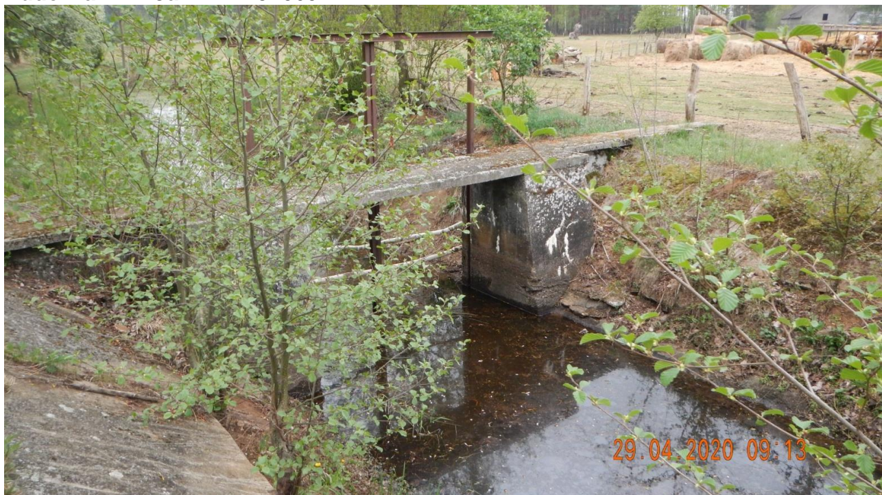
Budowla nr 2. Jaz w km 5+060
